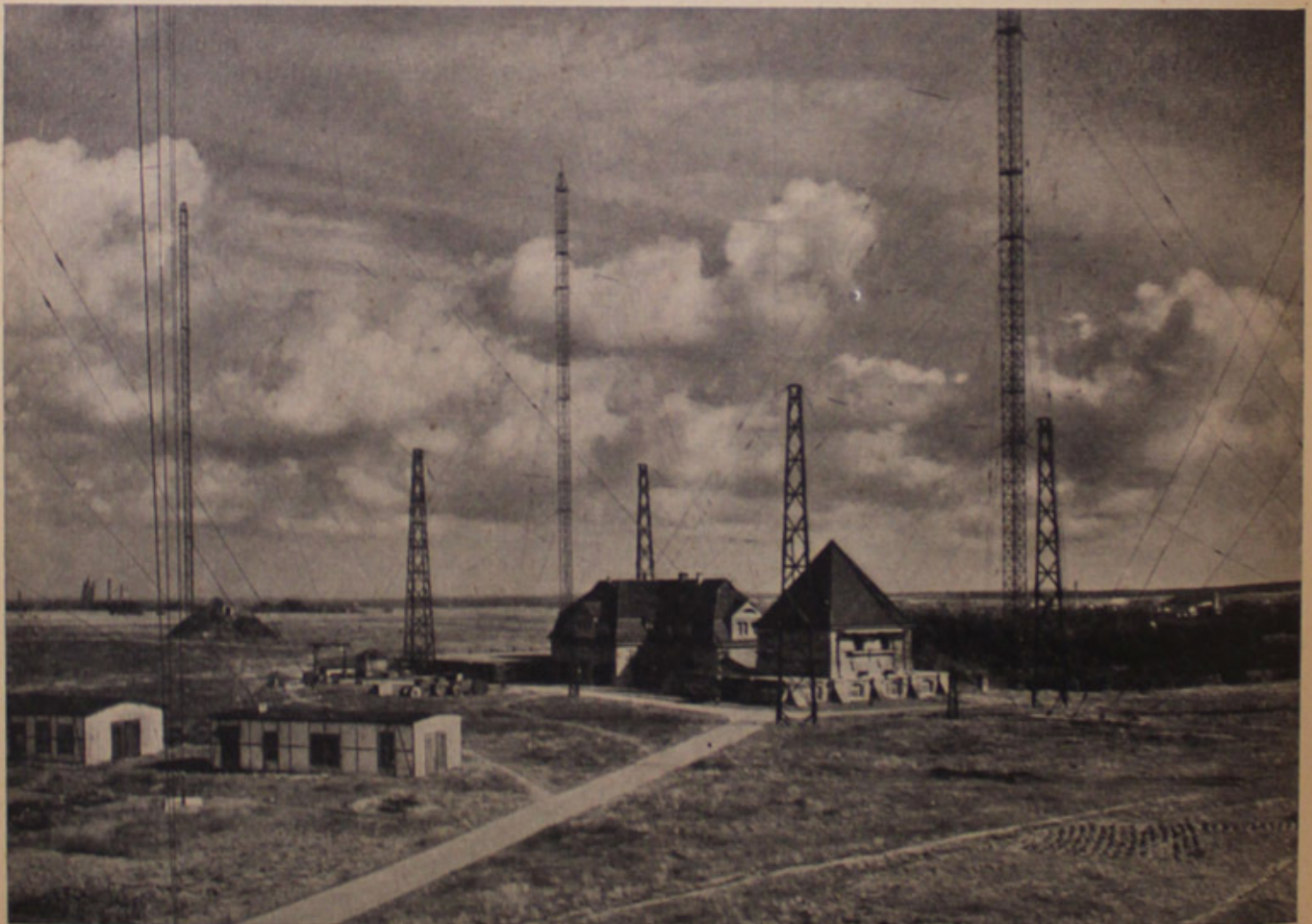
Bild 2. Die Hauptfunkstelle Königs Wusterhausen bei Berlin, die 1919 durch die Deutsche Reichspost von der Militärverwaltung übernommen wurde.
