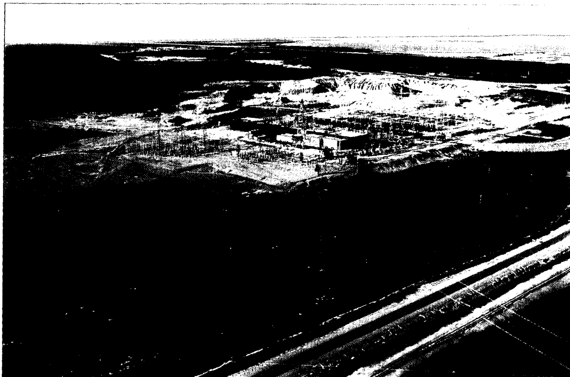
Poste de conversion Radisson du système H.T.C.C. de la rivière Nelson. Photo: Manitoba Hydro.
