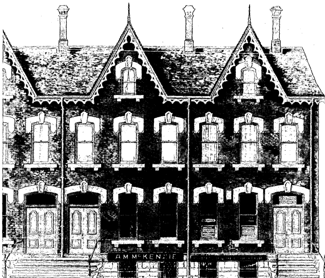
Premier central téléphonique de l'Empire britannique, érigé en 1878 au coin des rues Main et James, à Hamilton. Photo: Collection historique du téléphone de Bell Canada.
